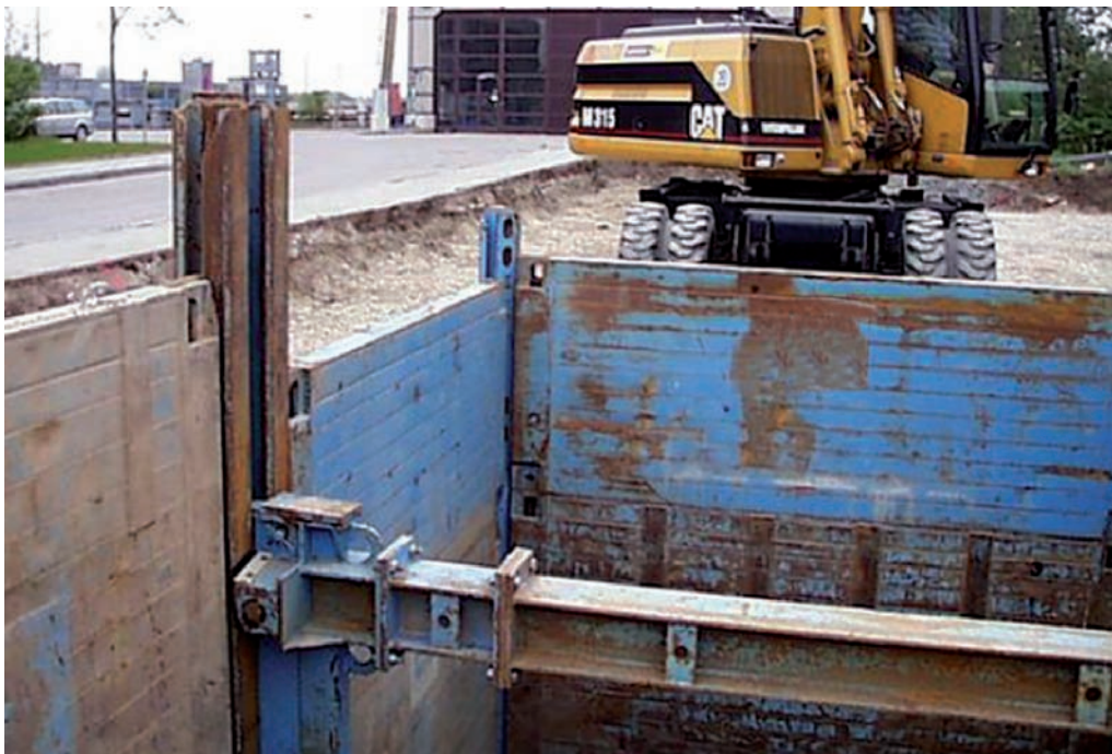
Figura 25 - Blindaggio con rotaie ad angolo (foto)
