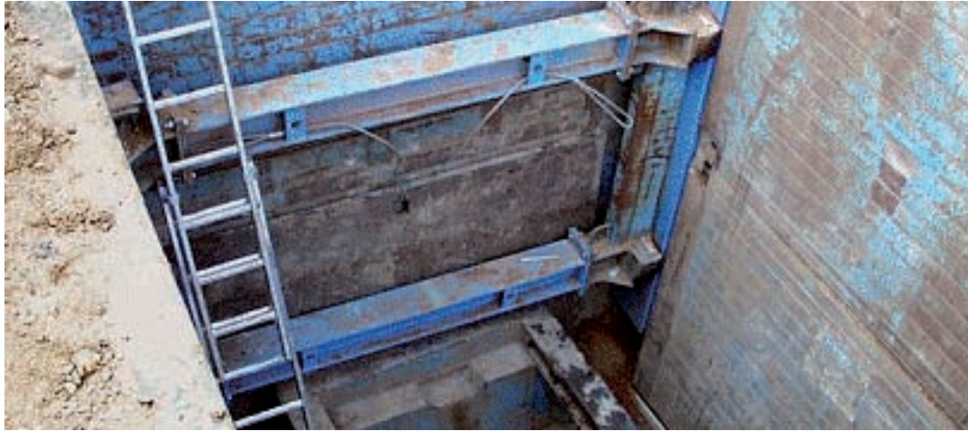
Figura 23 - Blindaggio di testata ad una rotaia (foto)
